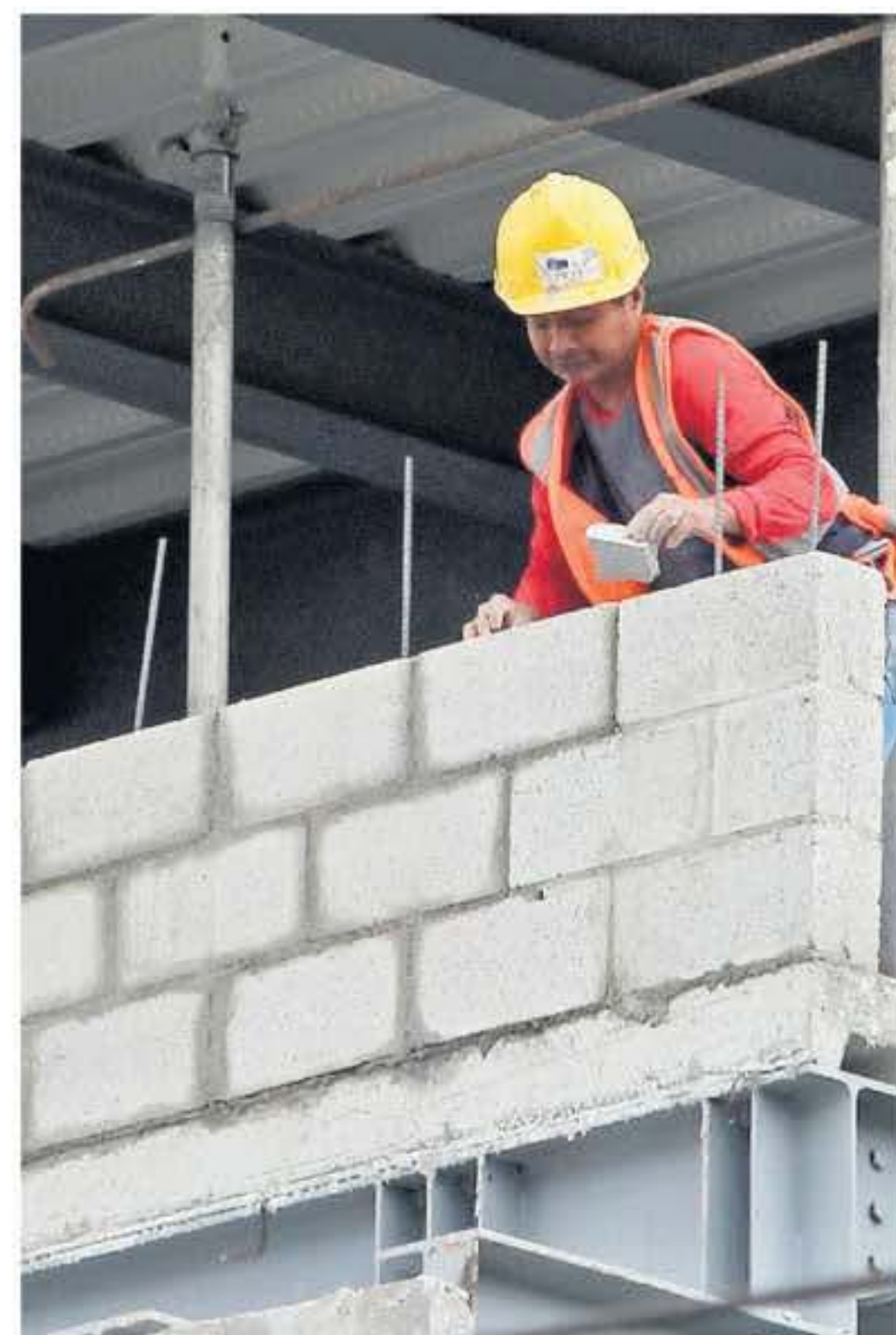
La construcción es una actividad productiva que utiliza mano de obra de forma intensiva.
